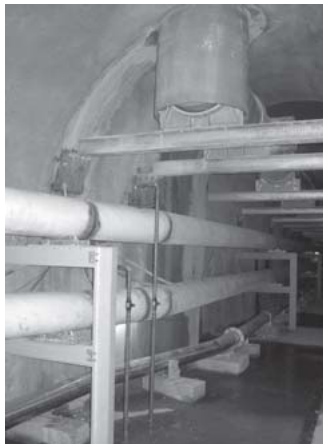
Pohled do interiérů kolektoru
