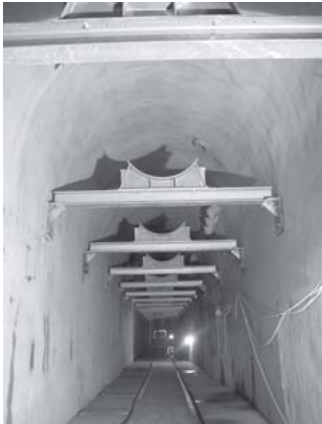
Pohled do interiérů kolektoru
