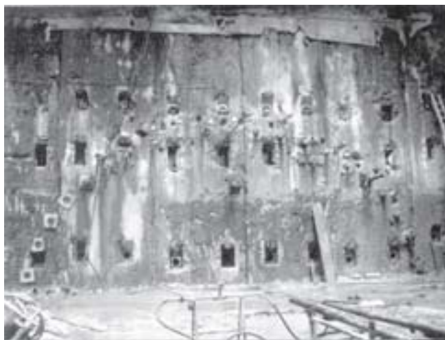
Horní část jedné ze štol před ražením se všemi vrti (kromě pěti) dokončenými. Těchto pět nedokončených vrtů je označeno čtvercovými ocelovými destičkami zcela vlevo. Pilotní vrt je uprostřed průřezu štol, cca 1,5 m pod nejvyšším vrtem.
