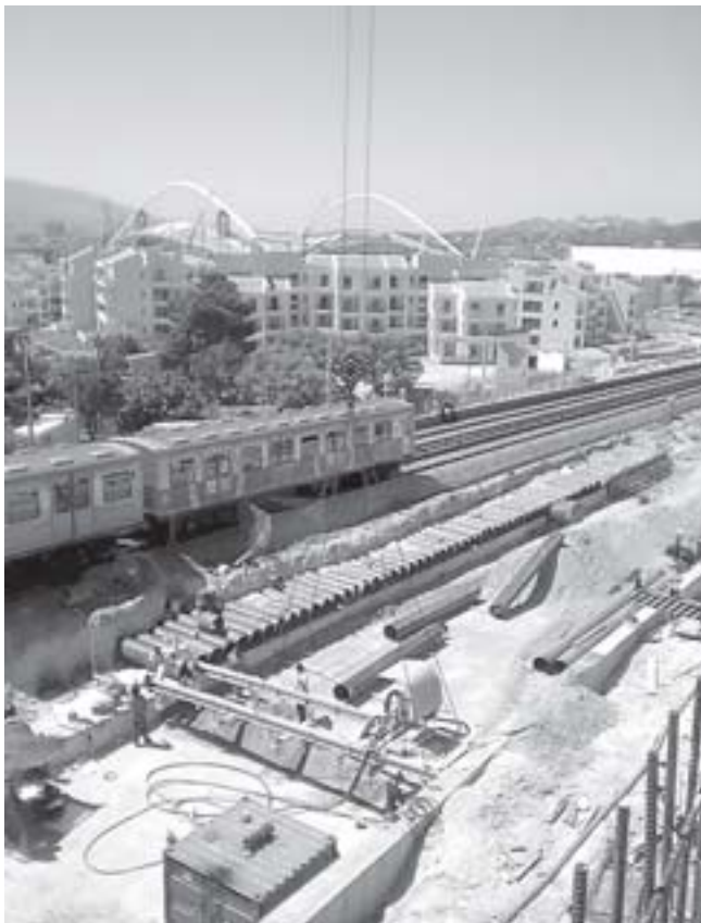
Obr. 3 Athény – zatlačování deštníkového stropu z trub DA 609 před dokončením
