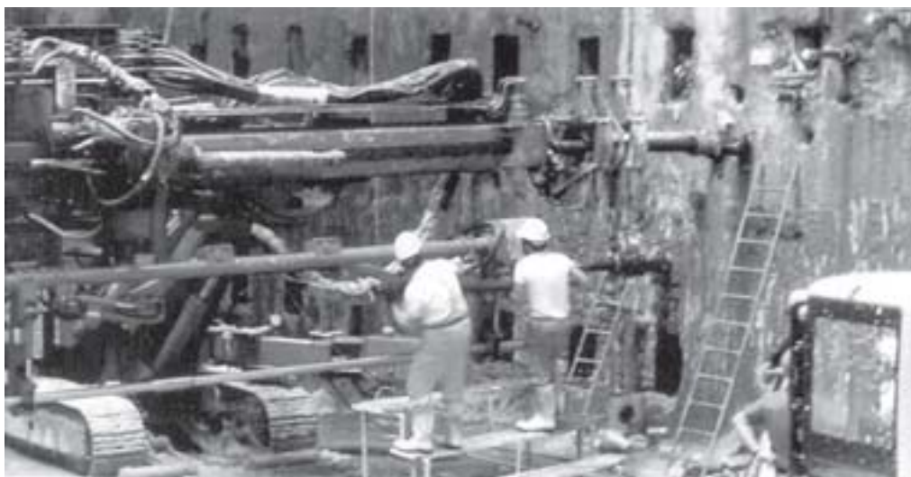
Vrtné práce v jedné ze štól za použití vrtné soupravy ETG 10 t s vrtnými trubkami 10 m dlouhými, které byly zkráceny na 9 m pro zkrácení času jejich připojení k sondě.
