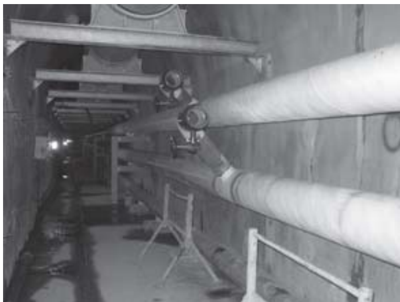
Pohled do interiérů kolektoru
