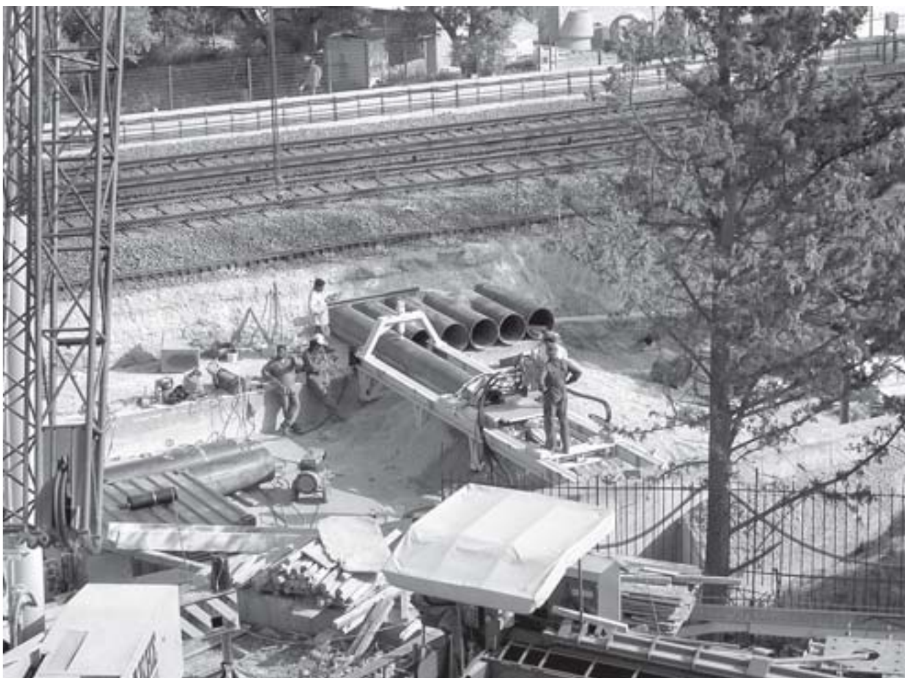
Obr. 2 Athény – zatlačování 6. trouby deštníkového stropu podchodu železnice
