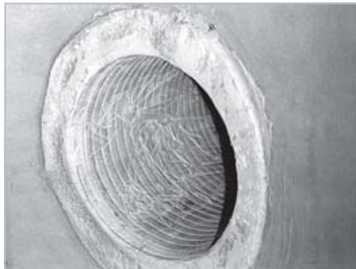
Detail napojení domovní kanalizační přípojky
