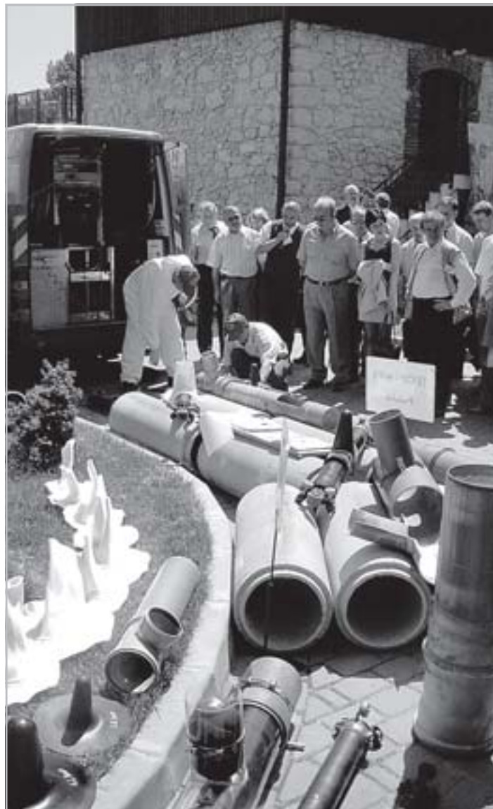
Obr. 3 – Ukázka sanace kloboučkovou metodou
