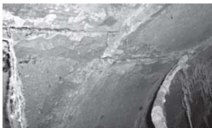
Obr. 4 – Podélná prasklina + prorůstání kořenů.
