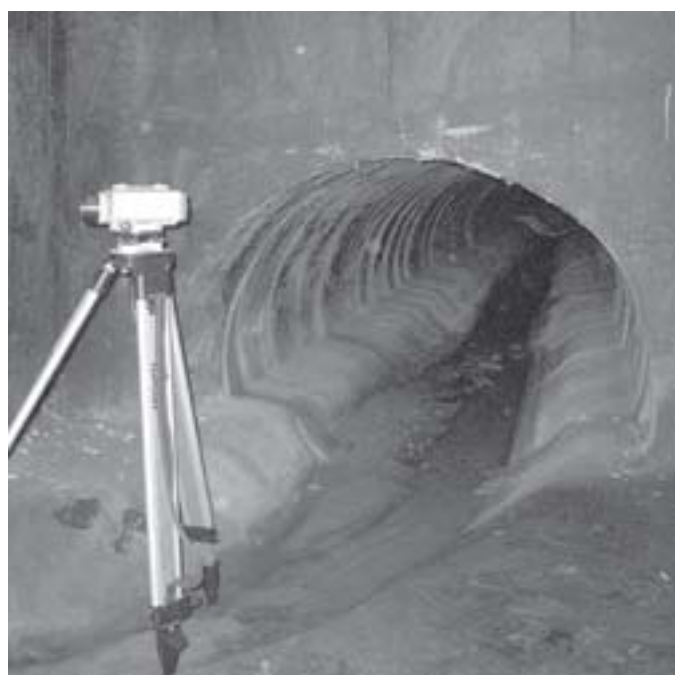
Obr. 6 – Umístění nivelačního přístroje v kanalizační šachtě.
