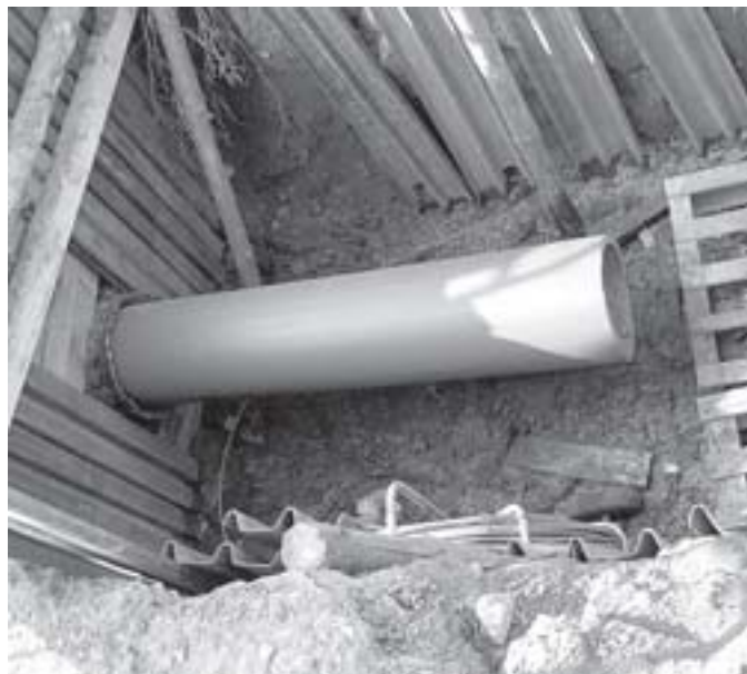
Obr. 4. Pohled do montážní jámy po reversi potrubí – další fází je propojení úseků a montáž armatur.
