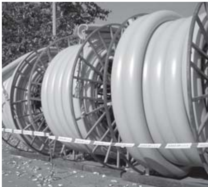
Obr. 2. Potrubí Compact Pipe navinuté na bubnech a připravené na staveništi pro instalaci.
