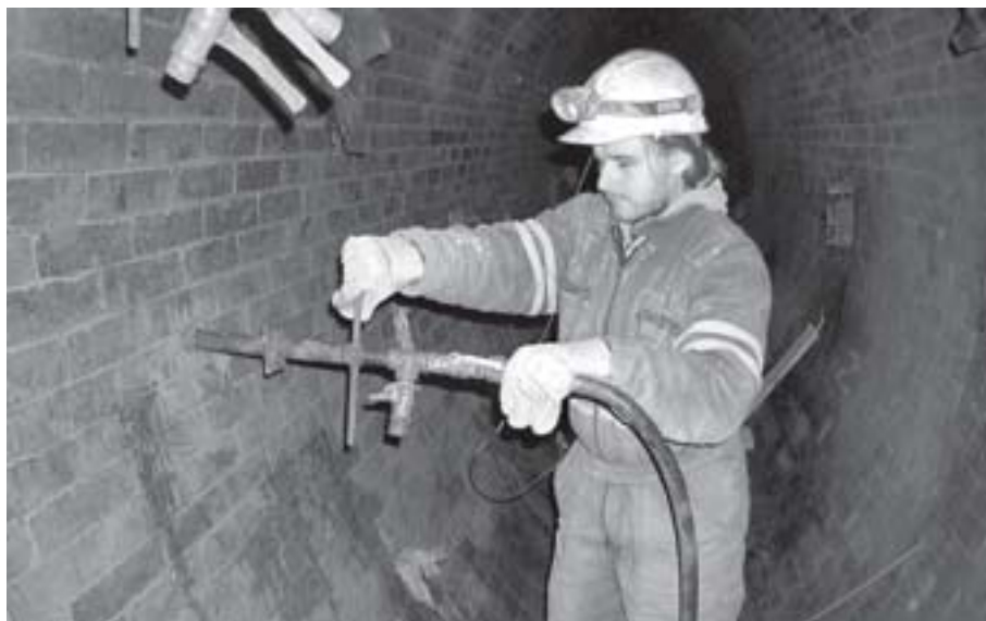
Osazení obturátoru.
