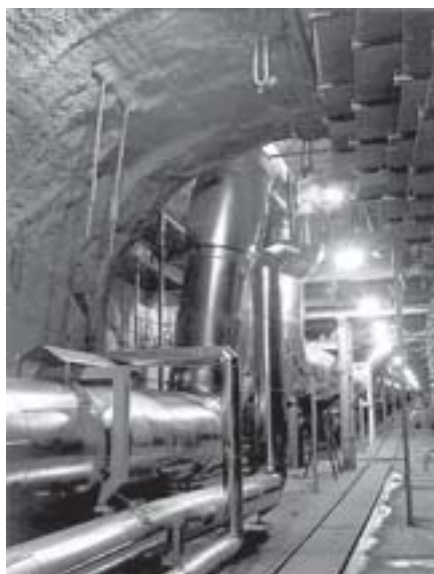
Sekundární kolektor před montáží technologického vybavení.
