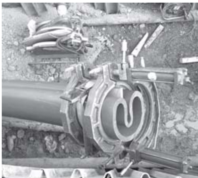
Obr. 3. Pohled na potrubí Compact Pipe po vtažení do opravovaného potrubí a před procesem reverse do kruhového tvaru.
