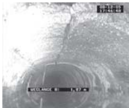
Obr. 1 – Označení poruchy podle ČSN EN 13508-2 je BAB – Tvorba prasklin.
