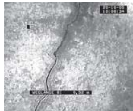
Obr. 1 – Označení poruchy podle ČSN EN 13508-2 je BAB – Tvorba prasklin.
