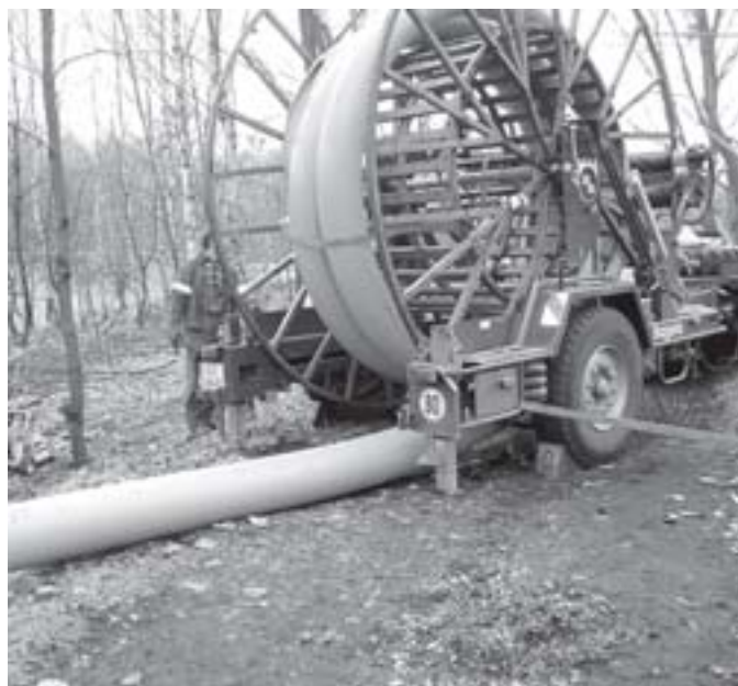
Obr. 1. Potrubí Compact Pipe se přes malou montážní jámu zatahuje do stávajícího ocelového potrubí.
