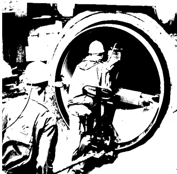
Obrázek č. 2 – zavážení nového profilu a obrázek č. 3 – fixace pozice po zavezení
