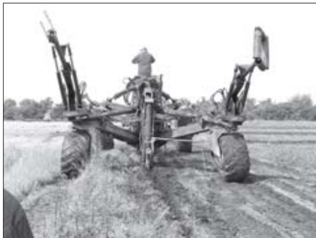
Obrázek 4: Brázda vzniklá při pokládce potrubí dn 355 mm na stavbě „Závlahový systém oblast Semice – Přerov nad Labem, oprava řady C6 a C6a“
