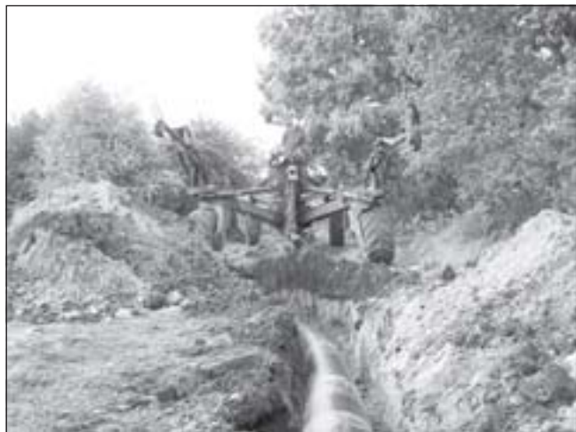
Obrázek 1: Začátek pokládky pluhem ze startovacího výkopu
