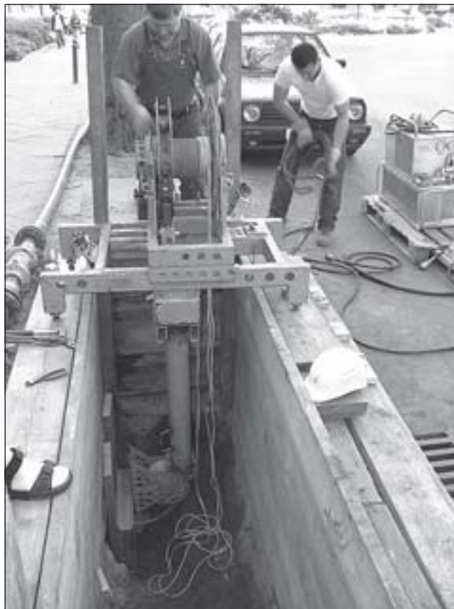
Obr. 2 – Zařízení hydros®LEAD při výměně přípojky
