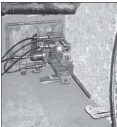
Obr. 4 – Zařízení hydros®BOY při výměně přípojky – instalace ve sklepě domu
