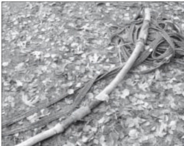
Obr. 6 – Přechod z olova na polyethylen po vytažení přípojky
