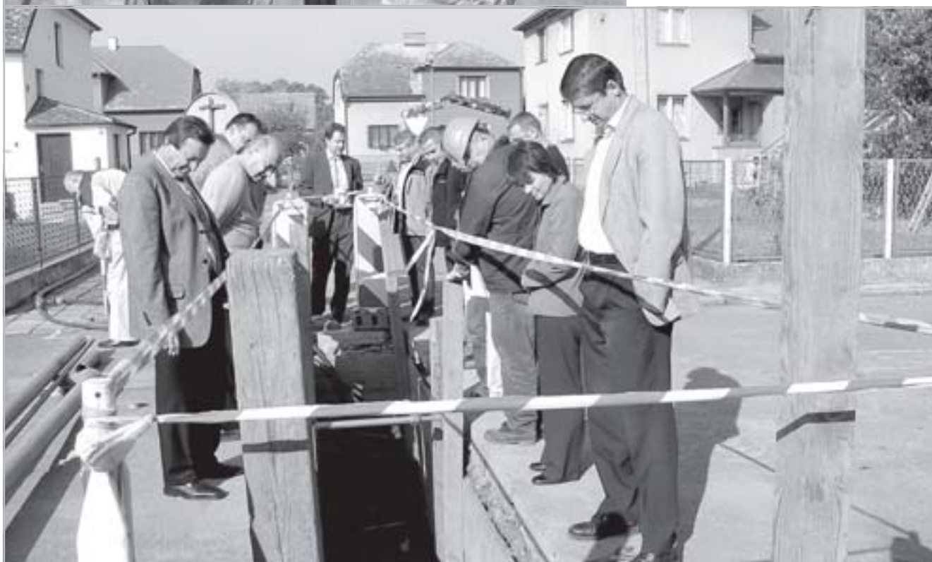
VAK-Stavby Hradec Králové, s.r.o. spolu s ČKV Praha s.r.o. předváděly pro účastníky konference na staveništi ve Smiřicích výměnu asbestocementového potrubí metodou hydros®PLUS.
