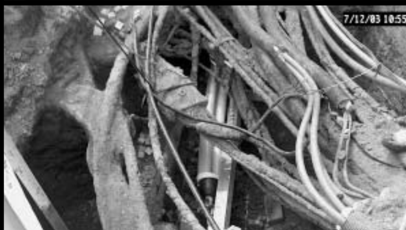
Ani takto zasíťovaná montážní jáma nezabránila instalaci „Compact Pipe“ do stávajícího plynovodu.
