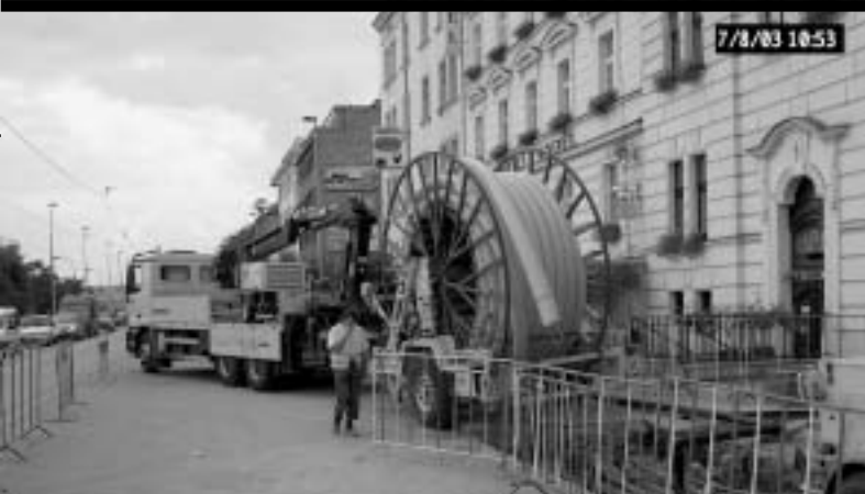
Staveniště s technologií „Brochier Compact Pipe“ v Radlické ulici.
